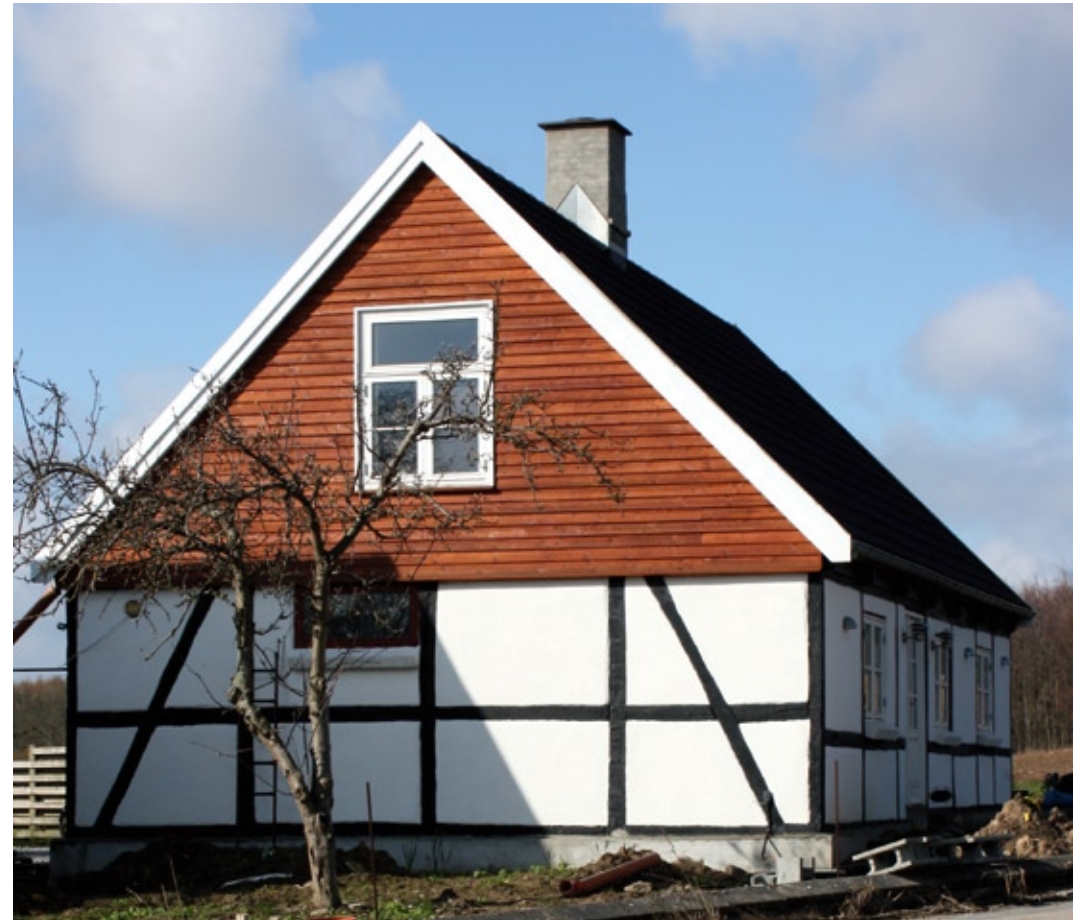
Et dårligt proportioneret tag med forkerte materialer, alt udført for at forbedre isoleringen, har ødelagt dette stakkels hus for de næste mange år. Vi nævner ikke engang vinduerne!
