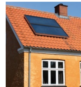
På et bevaringsværdigt hus er det absolut ikke foreneligt med hverken arkitekturen eller tegltagets klassiske udtryk at opsætte et så markant og fremmed element som solpaneler.
