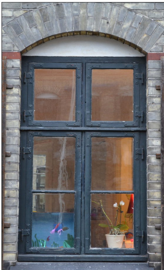
Ca 110 år gammelt vindue. Bemærk de store lysninger
