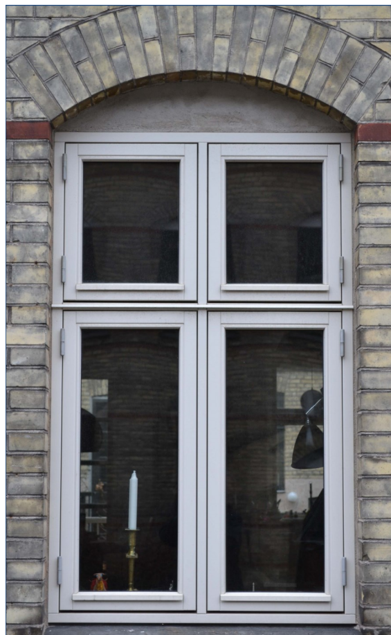
Termovindue fra nyere tid. Bemærk de smalle lysninger
