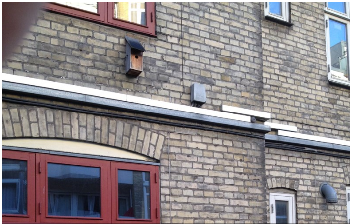
Coax-kablerne og andre, gamle kabler ligger i de hvide og grå plastikkasser på bagvæggen af vores huse
