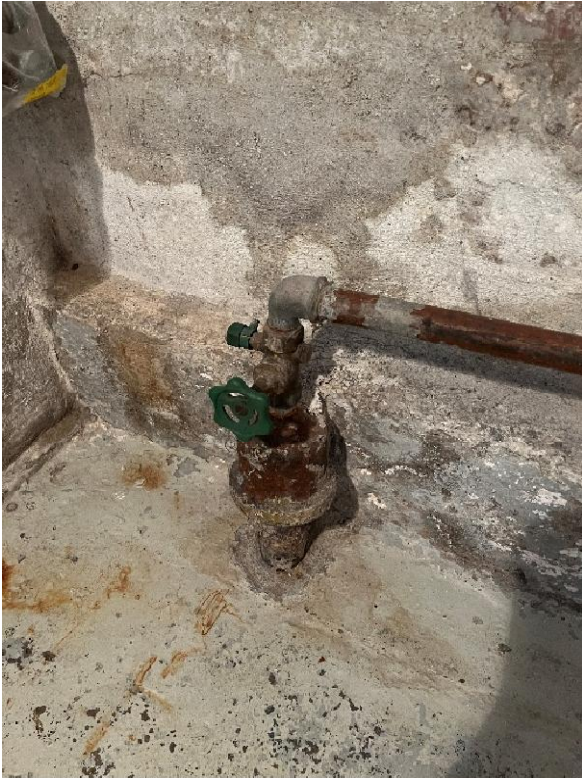
Eksempel på eksisterende gennemføring i murværk/fundament, og tilslutning i kælder.
