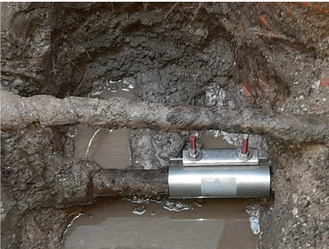
Eksempel på nødtørftig reparation af brud på støbejernsrør i baghaverne.
