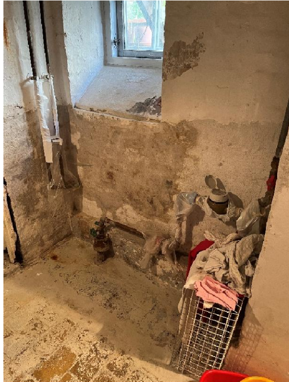
Eksempel på eksisterende gennemføring i murværk/fundament, og tilslutning i kælder.
