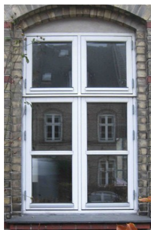
Renoveret vindue med midtersprosse
