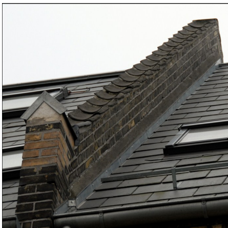
Eksempel på korrekt reparation af brandkam
