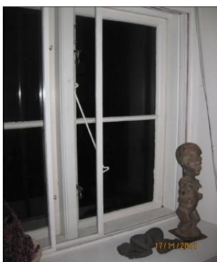
Forsatsruder på oprindeligt vindue
