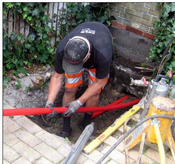
Carsten skubber kabelrøret igennem
