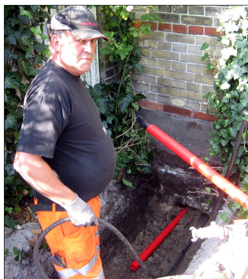
Carsten følger raketten på vej ud fra tunnel 2
