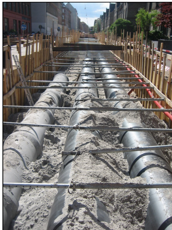
De nye rør i Landskronagade
